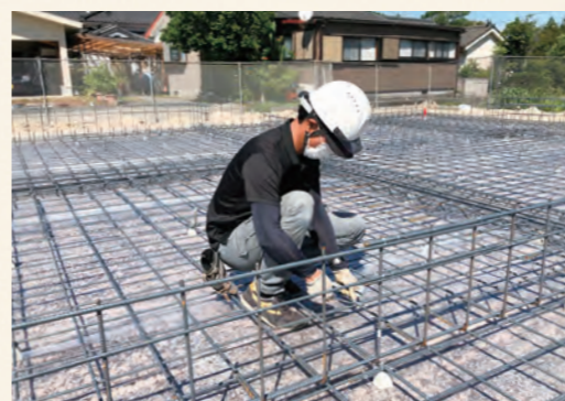
▲きれいに配筋された基礎工事
