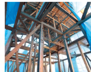
戸建てフルリノベーションは、外壁や内壁、サッシすべてを撤去し、新築でいうところの上檜の状態まで解体します。
