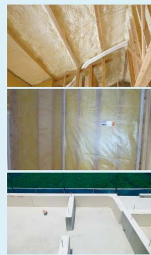
上/屋根断熱 中/壁断熱 下/基礎断熱
