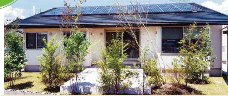
ママ目線のらくらくドライルーム
